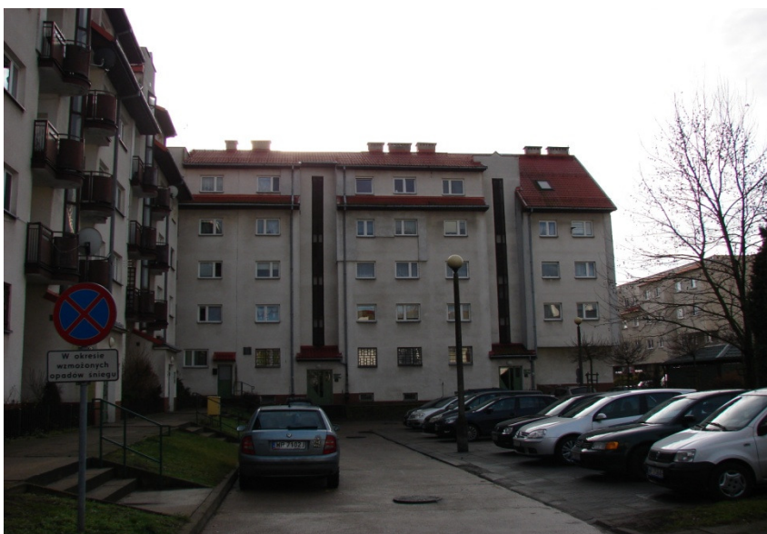
Fot. 2 Widok elewacji budynku od strony północnej
