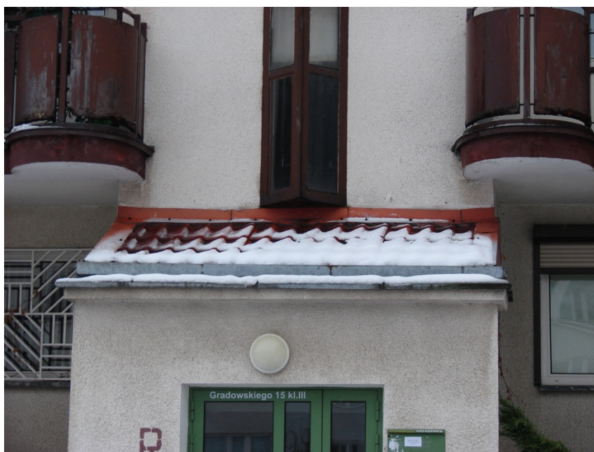
Fot. 5 Balkon loggia
