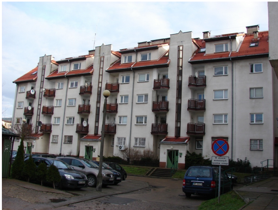
Fot. 3 Widok elewacji budynku od strony zachodniej
