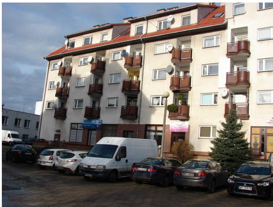
Fot. 4 Widok elewacji budynku od strony południowej
