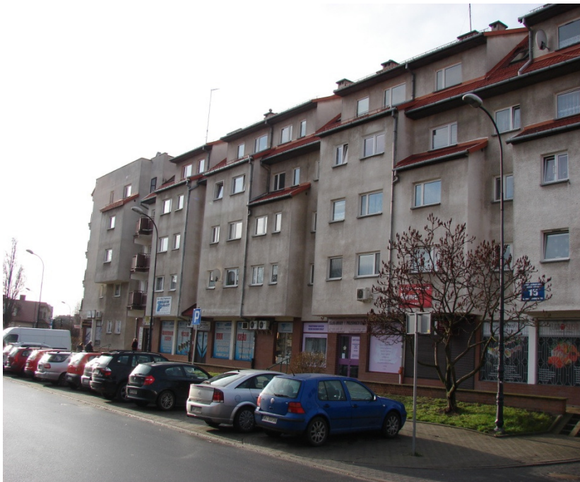
Fot. 1 Widok elewacji budynku od strony wschodni
